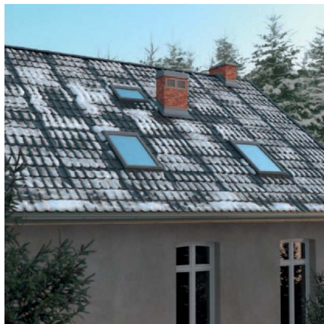
1. 3. | Príklad výskytu tepelných mostov - roztopeného snehu v miestach prenosu tepla krokvami na streche.
